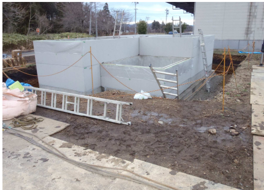
フルート据付
