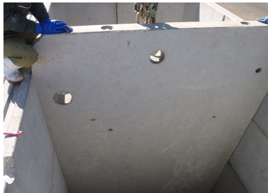
間仕切り壁設置
