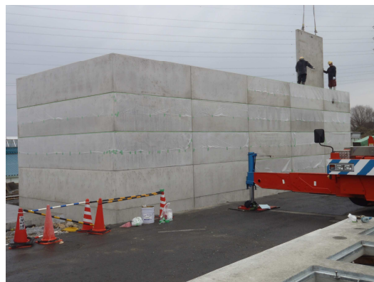
間仕切り壁設置
